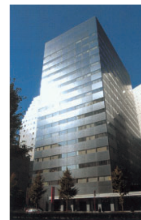
東京支店がある 新宿三井ビルディング二号館
