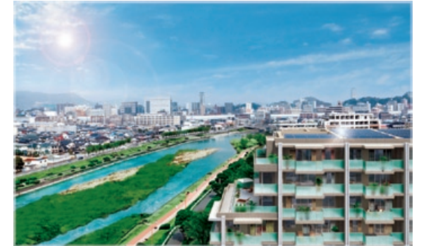
（グランフォーレ室見アクアコート ファミリーマンション48戸 平成26年1月完成）
