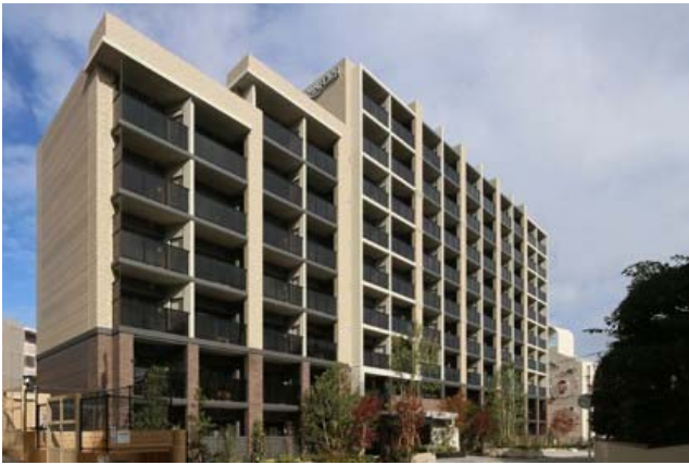
落ち着いたアースカラーと縦に走るラインや格子状の意匠をまとい、モダンな印象の外観
