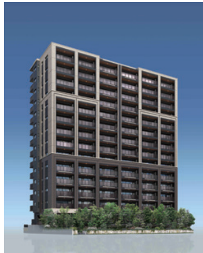
ファミリーマンション グランフォーレ大橋駅前レジデンス (83戸) 2022年12月完成予定 福岡市南区
