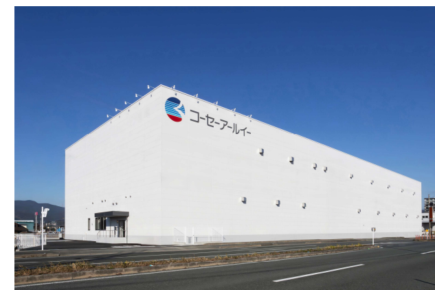
基山倉庫(佐賀県基山町)2026年1月完成
