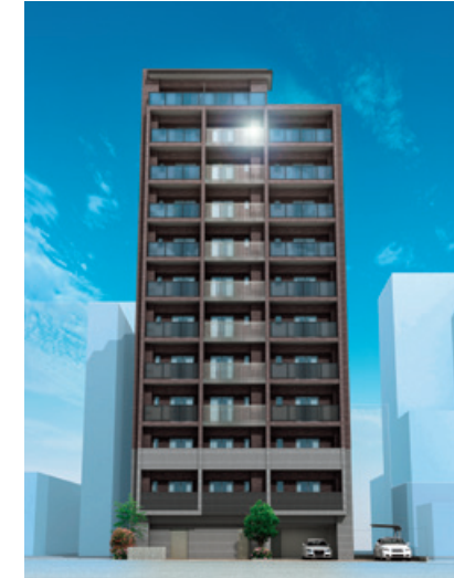
ファミリーマンション (仮称) グランフォーレ立川 (42戸) 2019年8月完成予定 東京都立川市
